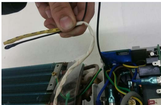
2. Provedte ho souběžně s továrním senzorem
